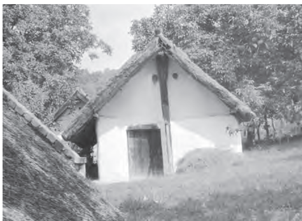
■ Kajárpéc. Faluból művelt szőlő, archaikus, ágasfás tetőszerkezetű préház pincéje (Józsa Tamás mérnök tanár, szakközépiskolai igazgató szíves közlése)
