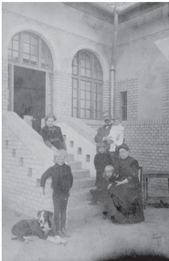
■ Győri Ottmár és családja 1910 körül a telep építési irodáját is magában foglaló lakásuk lépcsőjén, Zalán u. 6., ma Corvin körút 32. Az épület ezen részét annyira átépítették, hogy ez a lépcsőfeljáró már nem látható (KHGy)
