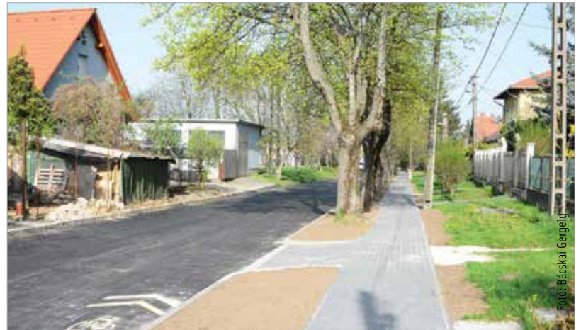
Új aszfaltburkolat és térköves járda az Adonyi úton
