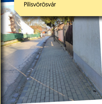
Járdaépítés a Széchenyi utcában
