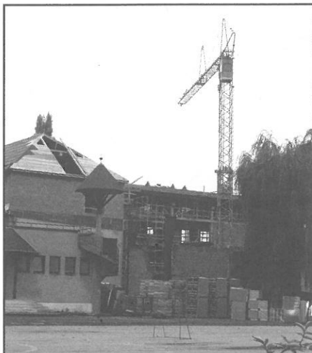
A gimnázium épülő tornaterme
