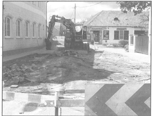
Megkezdődik a Szent Erzsébet utca felújítása
