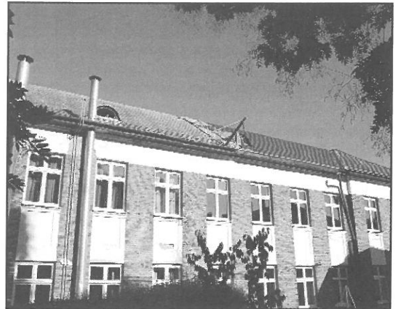
A Templom téri iskola északi épületszárnya: baloldalt a régi palatető, jobboldalt már az új cseréptető látszik
