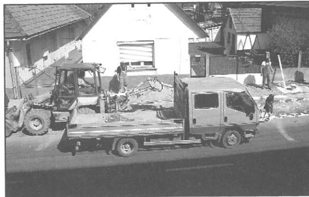
A Vásár téri iskola első emeletéről készült fotó a járdaépítés munkálatairól
