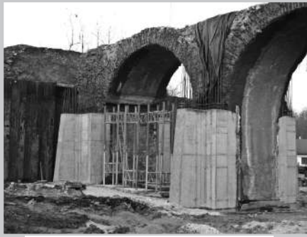
Épül a viadukt
