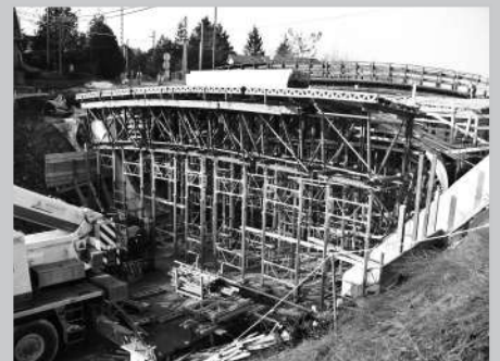
A Kálvária utcai híd aládúcok
