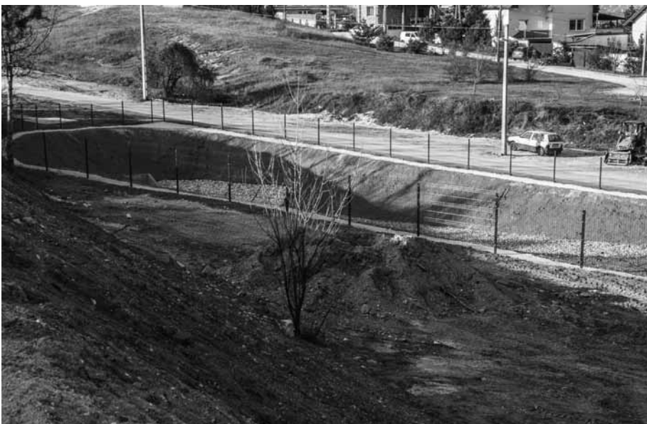
A csapadékvíz elvezetésére szolgáló vízszikkasztó Szabadságligeten, 500 m 3 földet emeltek ki
