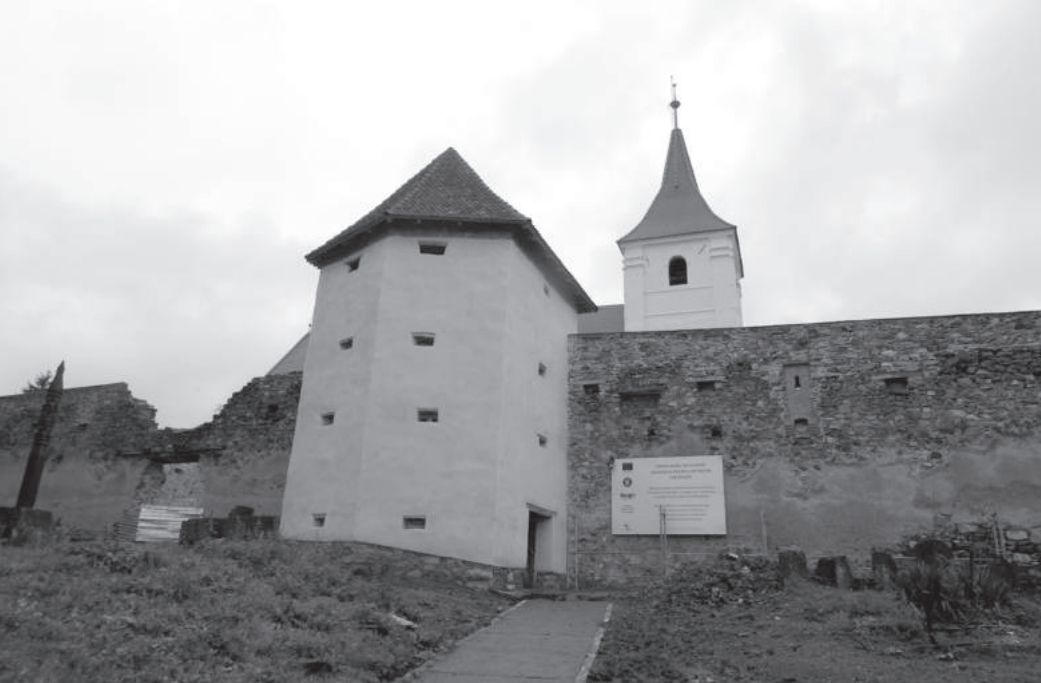
Nagyajta unitárius temploma felújítás alatt
