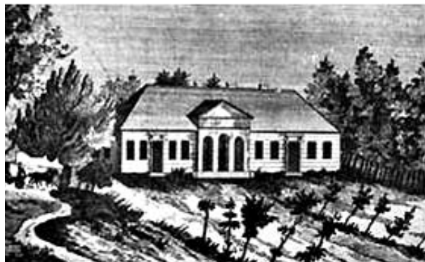
1. ábra. Az 1826-ben elkészült első fürdőház, mely Povolny Ferenc debreceni építőmester keze nyomán épült. A jellegzetes oszlopos, pilléres homlokzat a számos átépítés ellenére ma is látható
