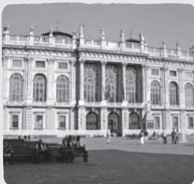
A torinói Palazzo Madama a tetőt elfedő mellvéd (attika) szobraival, urnáival, az ablakokat elválasztó függőleges falsávokkal és copfstílusú ablakszemöldökeivel a késő barokk korának jellegzetes épülete
