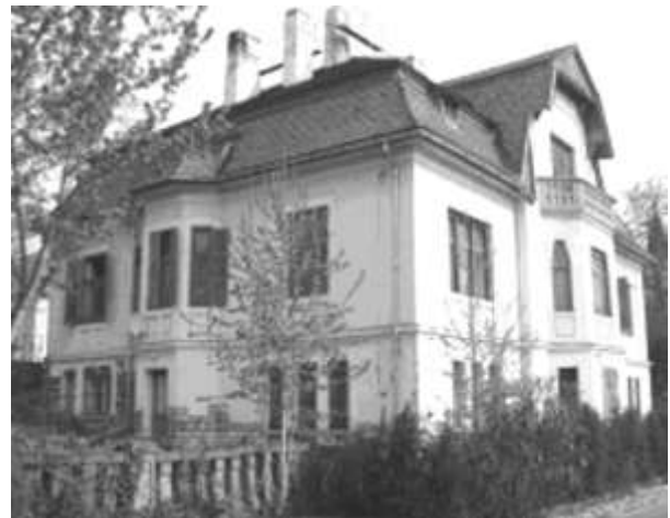
A Blaha utcai épület a felújítás előtt
