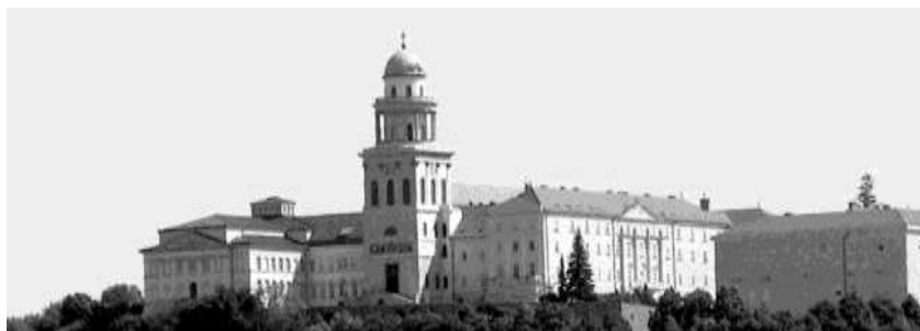
A Pannonhalmi Bencés Főapátság
