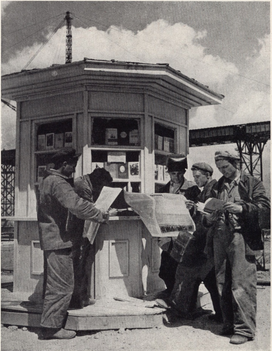
Épül a sztálingrádi vizierőmű. Újságos kioszk a főépület alapárkában
