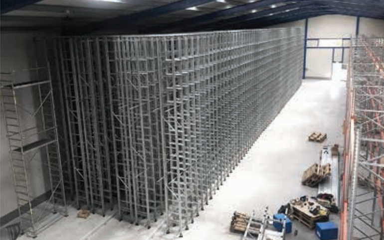
Építés alatt álló, 3 soros, több mint 5.000 ládaférőhelyes automata raktár
