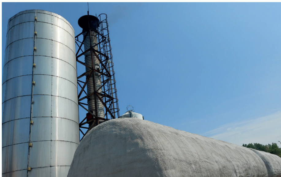
Takaréklángon üzemel még a biomasszakazán május első napjaiban. Mellette a szigetelt puffertartályok
