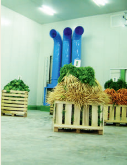
10000 t kapacitású zöldség-, burgonyatároló egy terme Agrole ISK 1000 légkeverő egységgel
