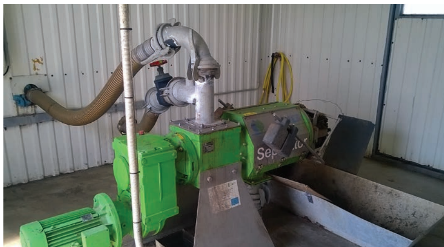
3. kép. Szilárd fázis leválasztása csavarorsós szeparátorral
