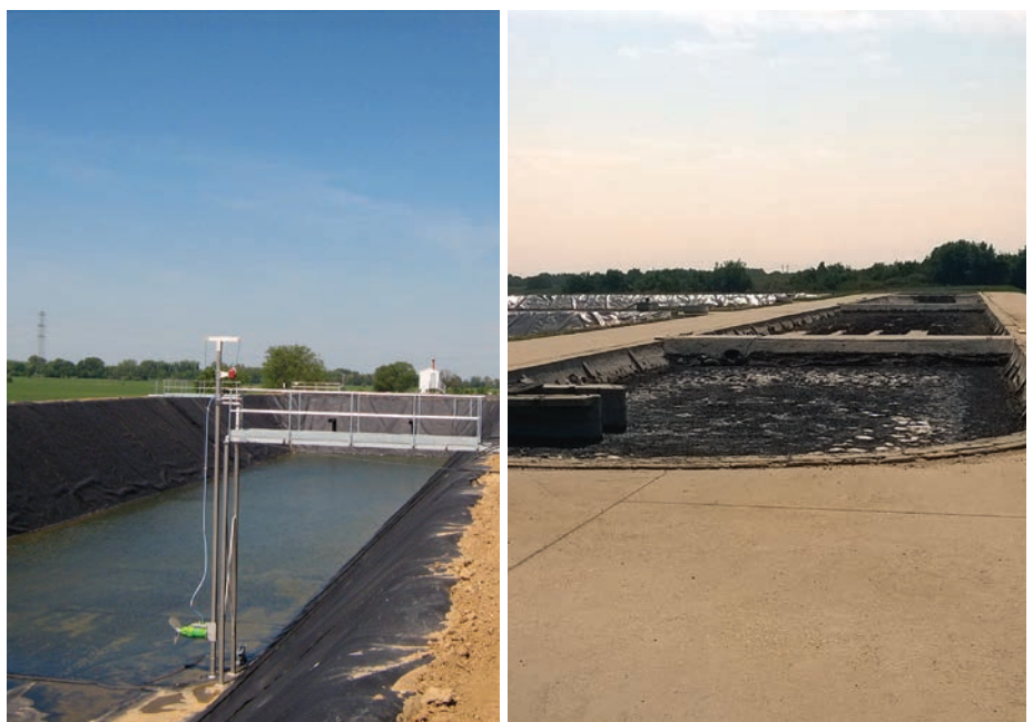
6. (a, b) kép. A hígtrágyamedencék bélelési megoldásai
