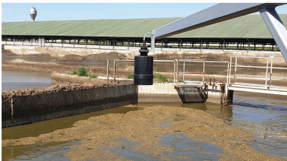
Trágyatároló medence ultrahangos szintmérése
