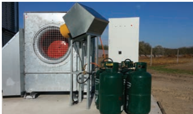
Alacsony hőmérsékletű szárítósiló egyik szellőztető ventilátora gázégővel, palackos gázellátással.
