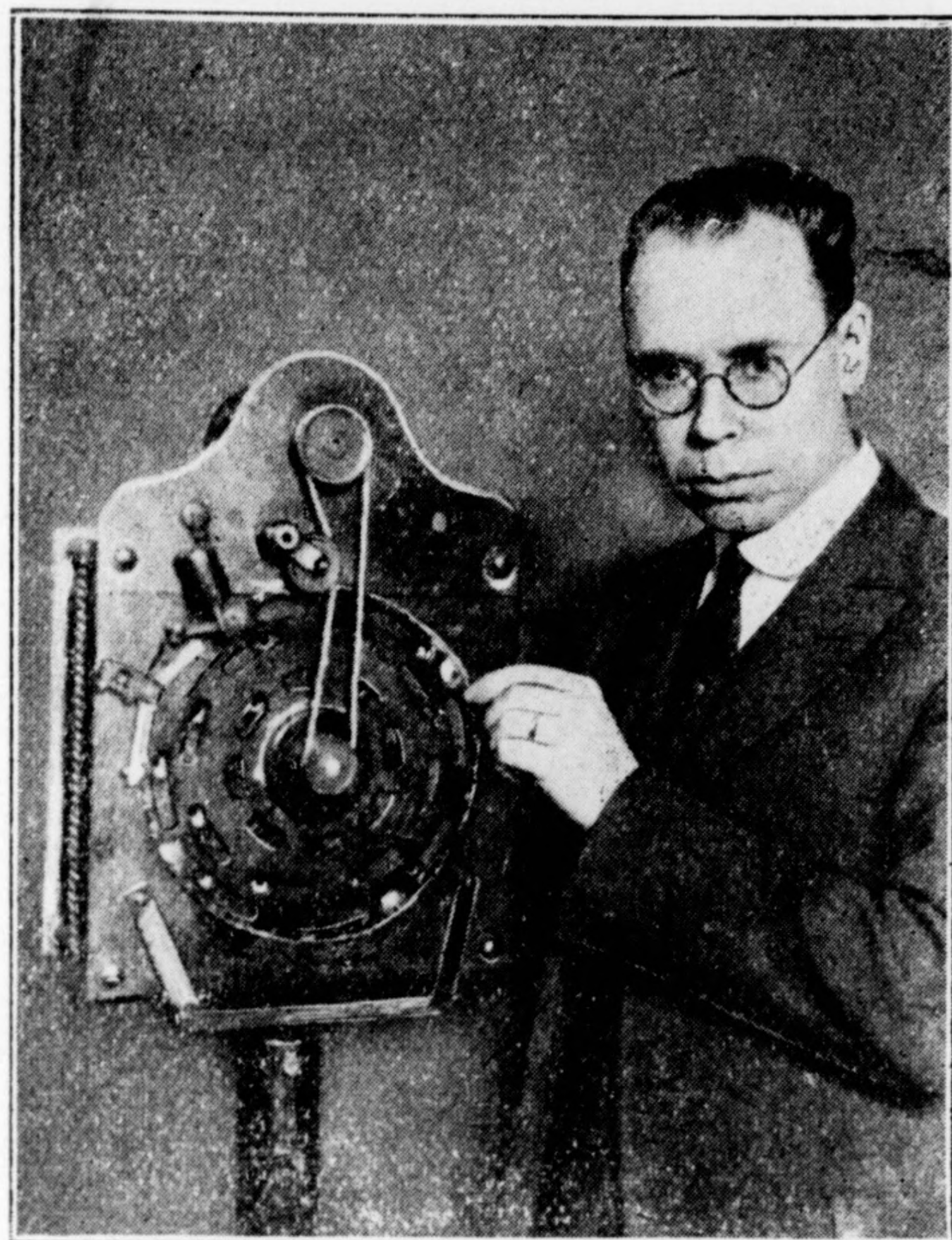
Másodpercenként 2400 felvételt készítő tudományos kinematográf.
