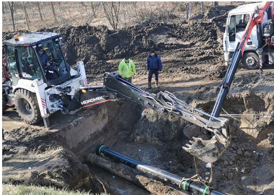
9. kép: Vecsés, 1500 m 3 -es medence, hálózati töltő vezeték havária
