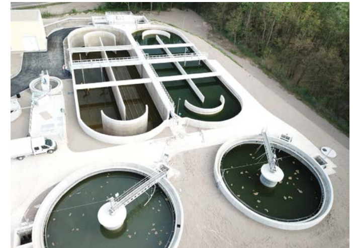
3. kép: Dunavarsány, szennyvíztisztító telep felújítása
