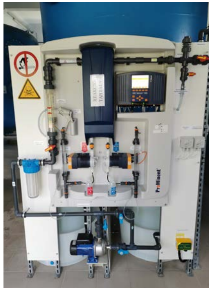
6. kép: Üllő, klór-dioxid-előállító és -adagoló beüzemelése
