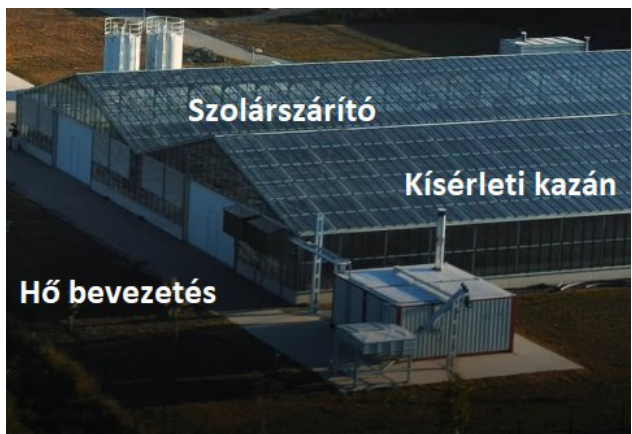
5. ábra: Kísérleti kazán és a szolárszárító
