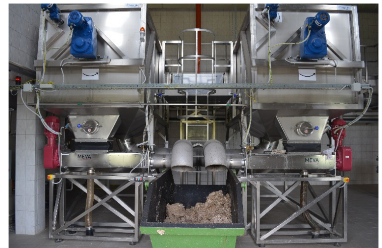
1. fénykép: Ikresített finomszűrő
