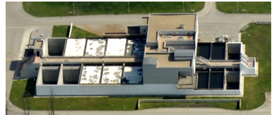
1. ábra: BIOFOR™ nitrifikációs (balra) és utódenitrifikációs (jobbra) bioszűrők
