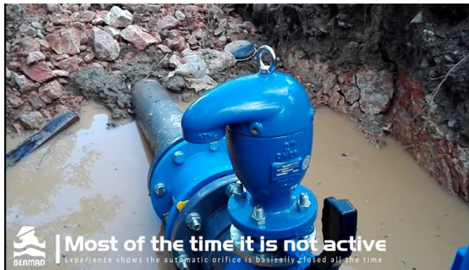
5. ábra: Légbeszívó-légtelenítő szelep működés közben Link: https://www.youtube.com/watch?v=8bwOpOSgFug
