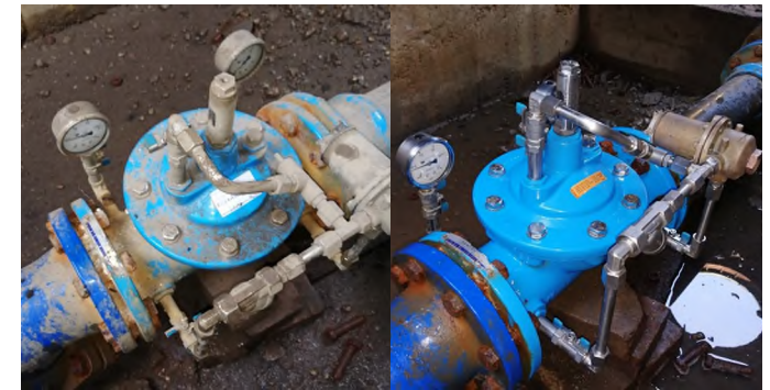
9. ábra: Hawido szelep javítása, Csongrád megye
