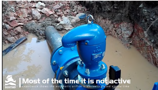
5. ábra: Légbeszívó-légtelenítő szelep működés közben Link: https://www.youtube.com/watch?v=8bwOpOSgFug
