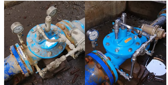
9. ábra: Hawido szelep javítása, Csongrád megye
