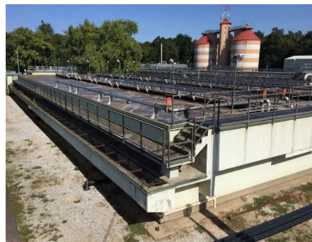
3. ábra: A nyíregyházi szennyvíztisztító telep biológiai fokozata (a háttérben a rothasztóberendezés)
