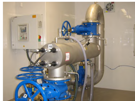
Korszerű, UV-s fertőtlenítőberendezés az Aranyosvölgyi vízbázisnál
