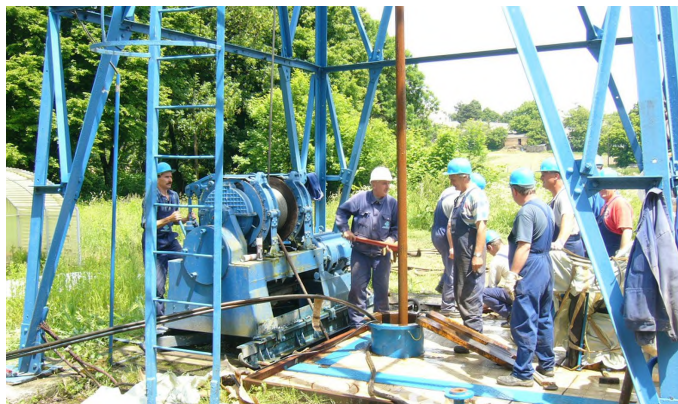
Búvárszivattyú-csere az 503 méter mélységű zirci II. sz. karsztkútbán
