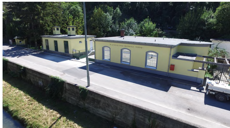
A Víziközmű Múzeumnak otthont adó, felújított 125 éves vízműgépház
