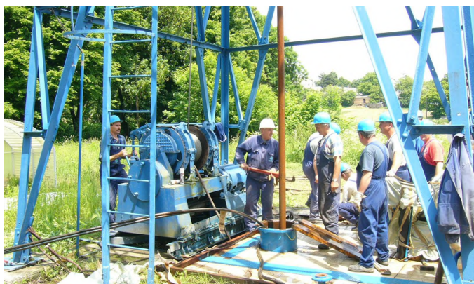
Búvárszivattyú-csere az 503 méter mélységű zirci II. sz. karsztkútban
