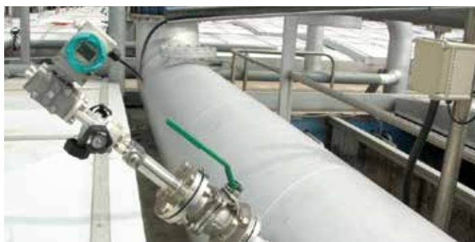
Pitot-csőves térfogatáram mérés szennyvíztelepen
