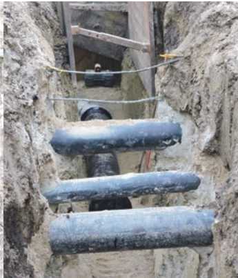
5. ábra: Vezeték fektetése folyamatos szintezéssel
