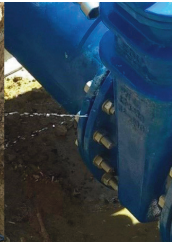
9. ábra: Az elégtelen nyomáspróba oka
