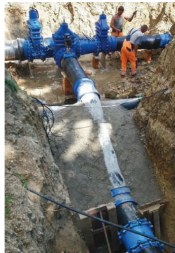
8. ábra: Csomópont szerelése a vízműtelepen
