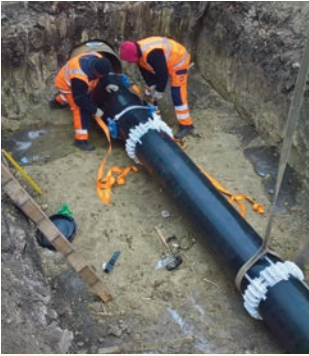
3. ábra: DN 400 GÖV-cső fektetése
