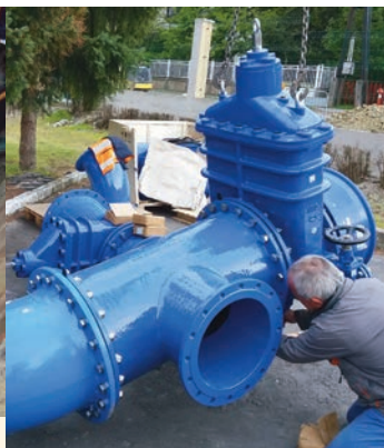
7. ábra: Csomópont összeszerelése a felszínen
