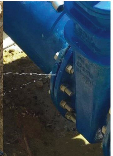
9. ábra: Az elégtelen nyomáspróba oka
