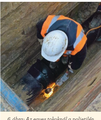
6. ábra: Az egyes tokoknál a polietilén védőréteg folytonossága érdekében zsugorfólia került elhelyezésre
