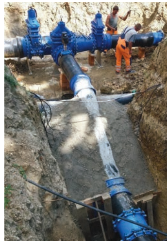
8. ábra: Csomópont szerelése a vízműtelepen
