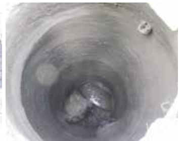
7. kép: Korrodált beton tisztítóakna - javítás után
