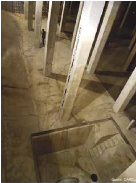
2. ábra: Egy ivóvíztároló egészségügyi tisztítása képzett személyzetet, higiéniailag kifogástalan munkaeszközöket és ennek biztosításához szükséges minőségi tisztítószereket követel meg.
