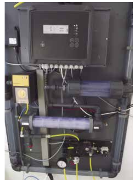
6. ábra: A berendezés lelke, a NaCl-oldat-bontó, hipó-előállító és vezérlő részegység
