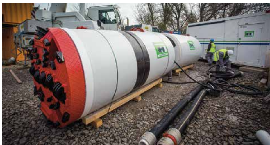
A fúrópajzs összeállítása a XXII. kerületi Gyár utcában
