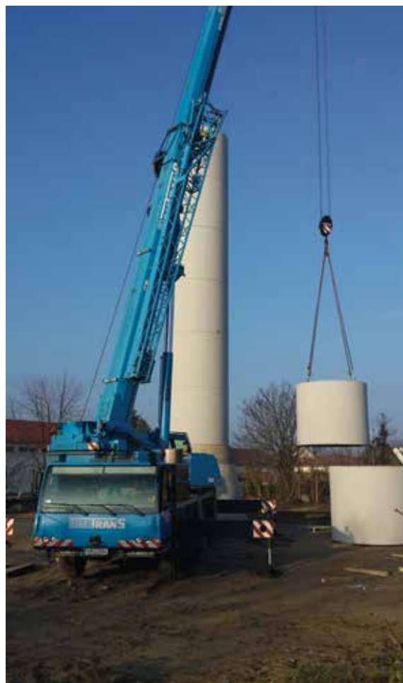
Víztorony – toronytörzs építése
