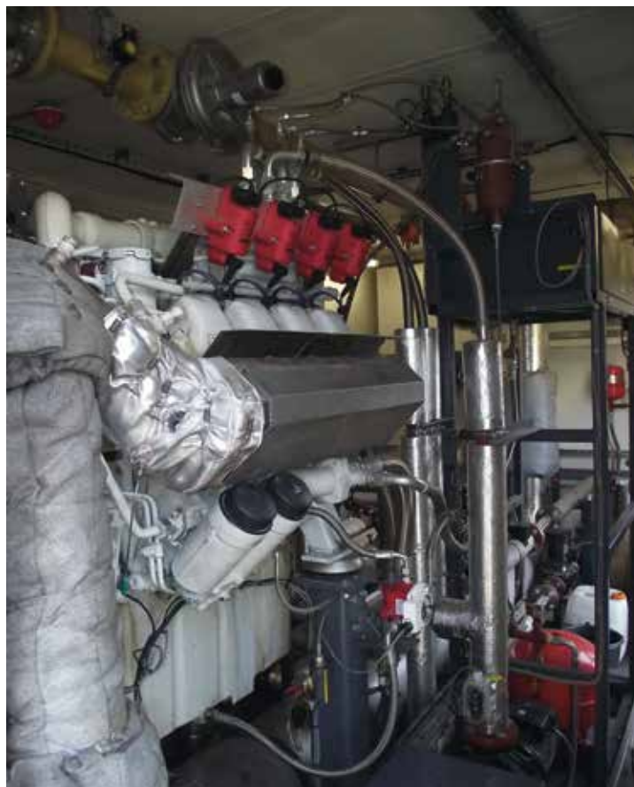
A 2010-ben, Veszprémben üzembe helyezett MAN típusú gázmotor
