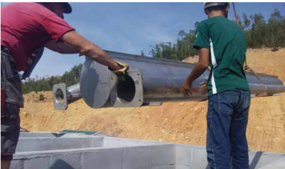
Pillanatkép a kivitelezés közben
