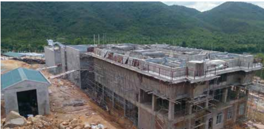
A víztisztító mű építése (2015 október)
