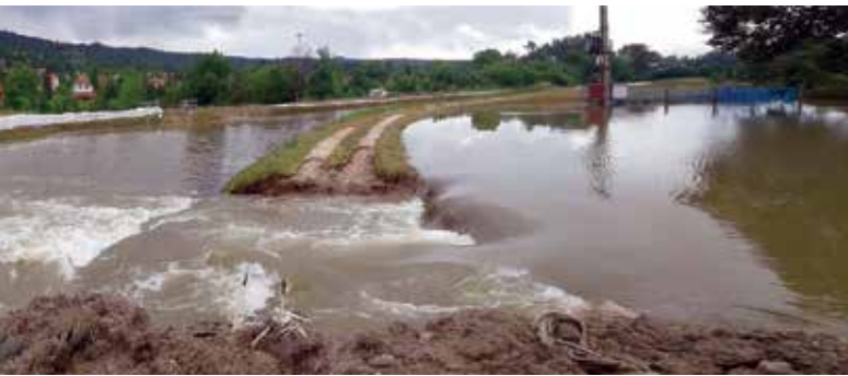
A Dunaalmás 2.sz. kút tetőzés utáni vízviszavezetése gátmegbontással
