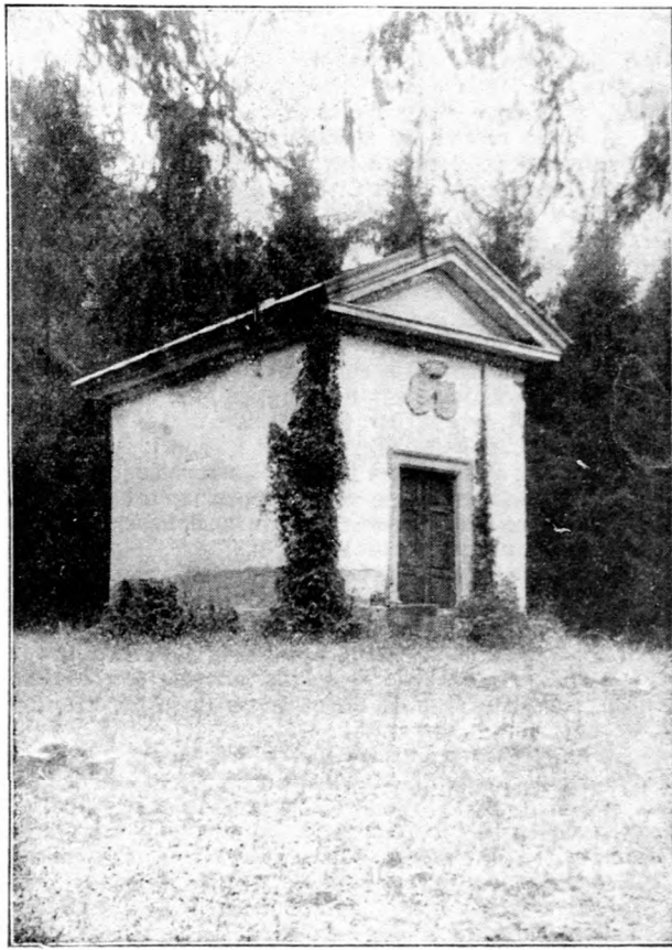
A Bethlen grófok családi sírboltja Mezősámszondon. Csupán ezt hagyták meg a románok a miniszterelnök tulajdonában.
