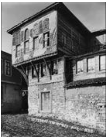
A Rákóczi ebédlőházaként ismert rodostói épület, 1905 előtt
