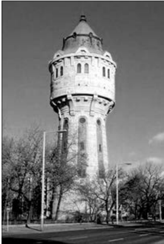
A VÍZTORONY (ÉPÜLT: 1911–1912)
