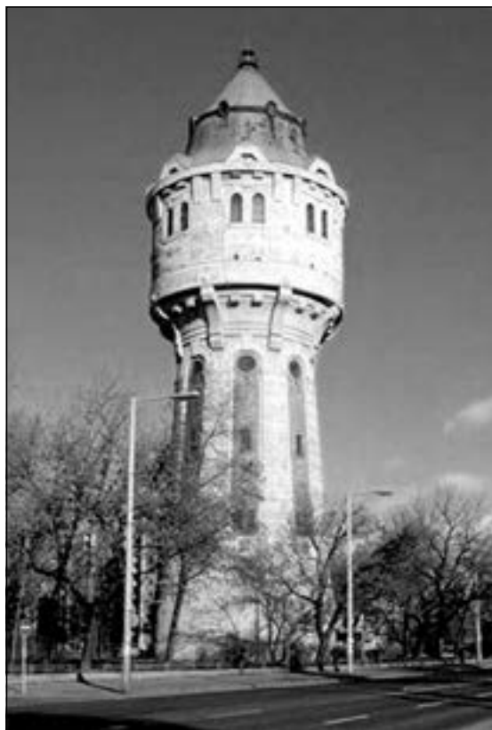
A VÍZTORONY (ÉPÜLT: 1911–1912)
