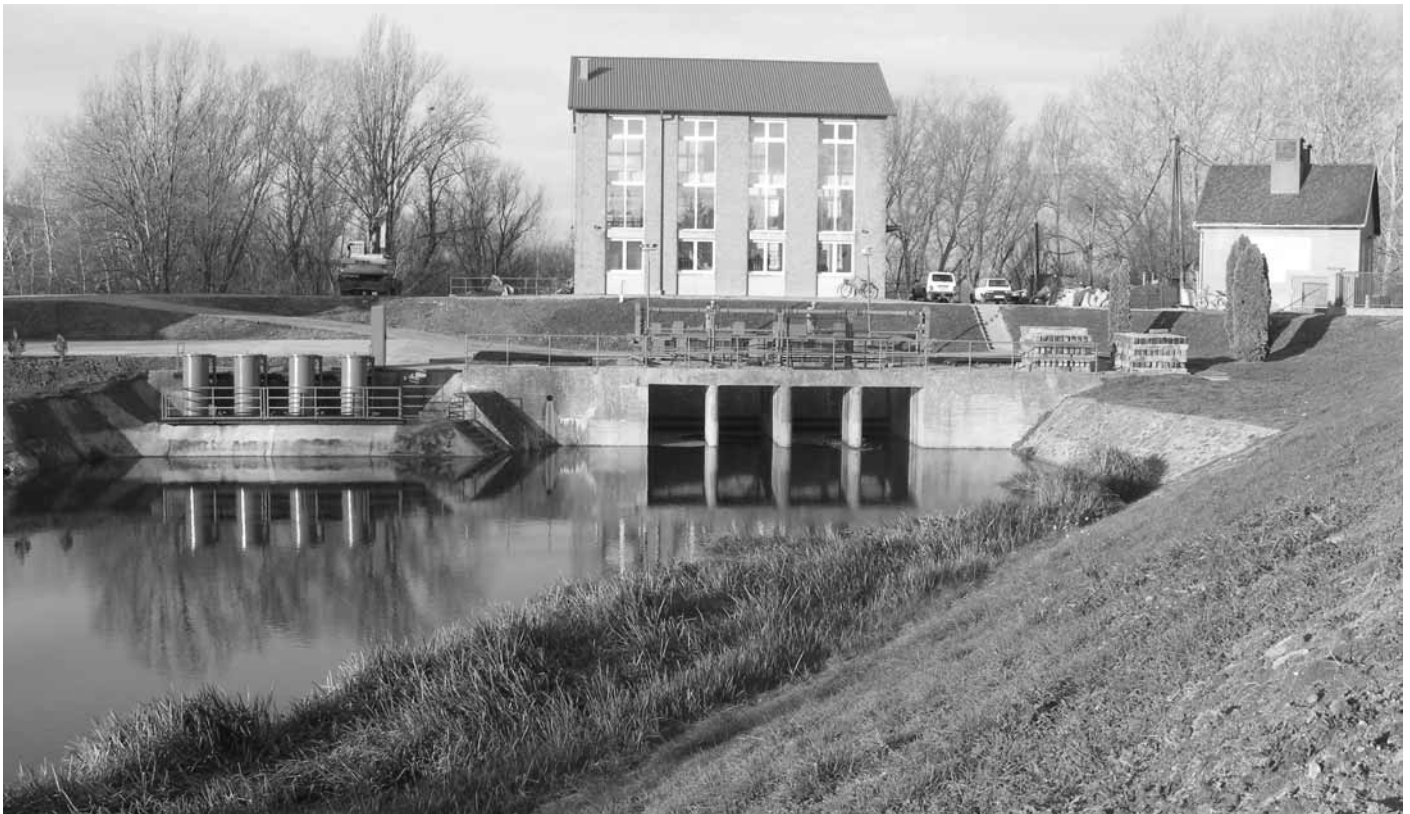
A Duna-völgyi-főcsatorna (DVCS) torkolati szivattyútelepe
