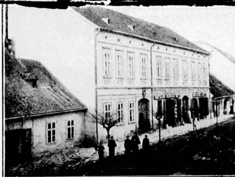
Községi általános takarékpénztár.
