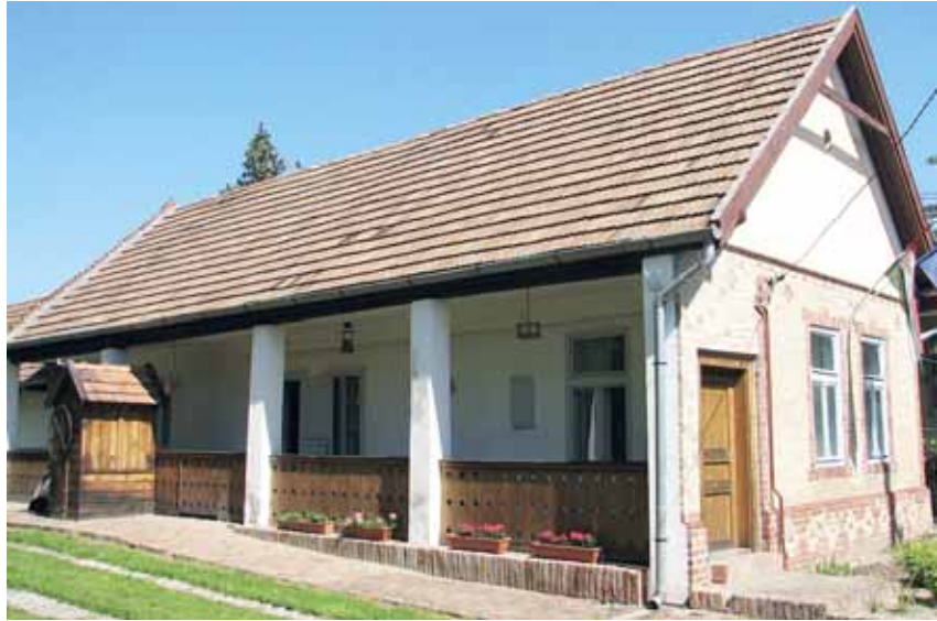
Az épület homlokzata klinkertéglával díszített
