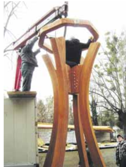
A harangláb felső koszorújának szerelése
